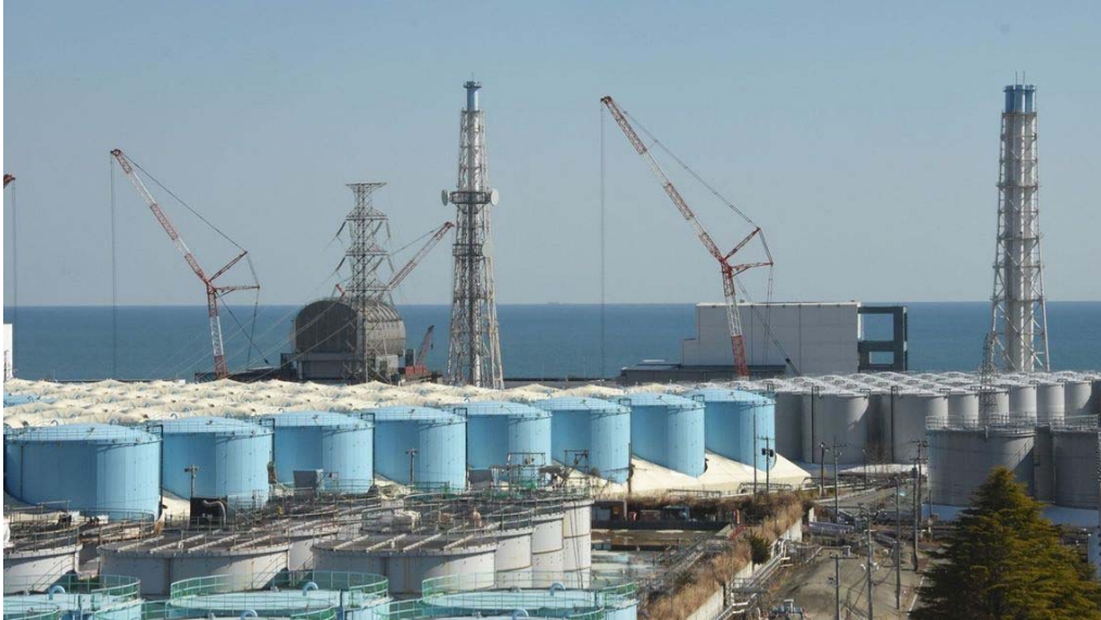
福島第一原子力発電所には、汚染水を浄化処理した水タンクが立ち並ぶ（写真：代表撮影）
