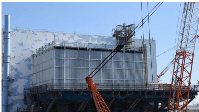
2号機はまだ原形をとどめている（写真：代表撮影）
