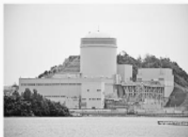
関西電力美浜原子力発電所3号機(福井県美浜町)
