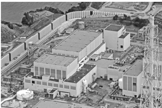
女川原発2号機（高き20mES防潮堤）
