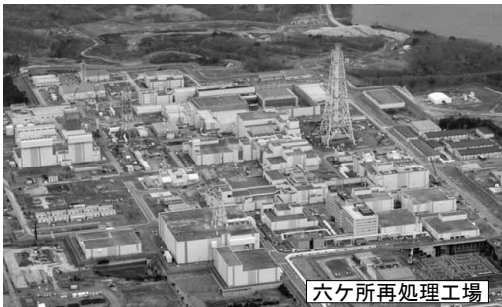
六ヶ所再処理工場
